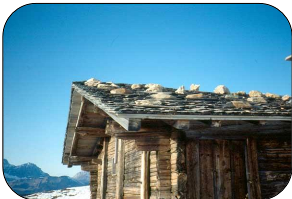
Toiture couverte en bois (grenier aux Saisies)
