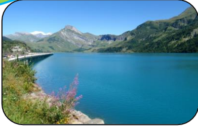
Le barrage de Roselend, Savoie
