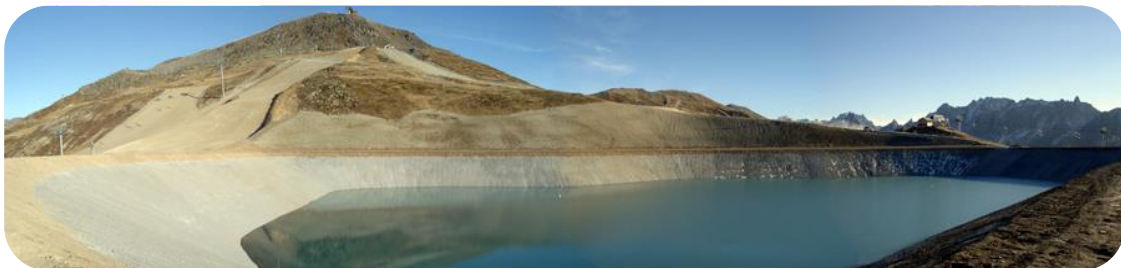
Retenue collinaire à Valloire, Savoie
