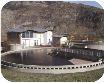
Station d'épuration de Saint-Jean-de-Maurienne
