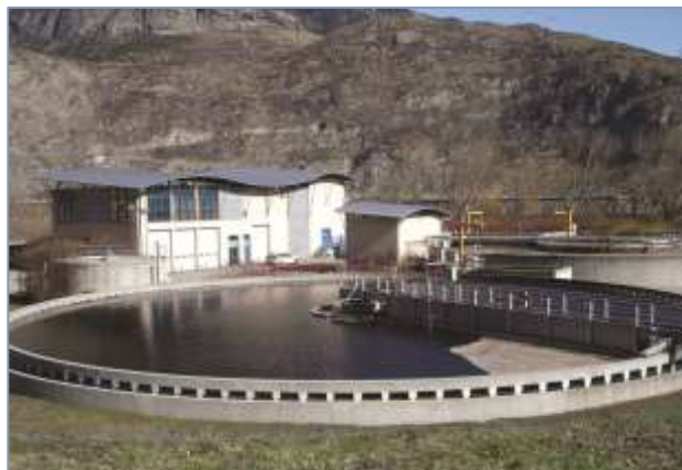
Station d'épuration de Saint-Jean-de-Maurienne (Photo B. Juillard)
