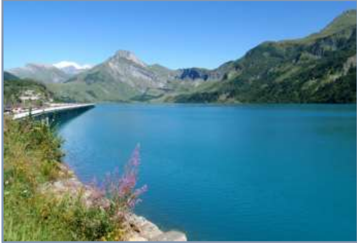
Le barrage de Roselend, Savoie
