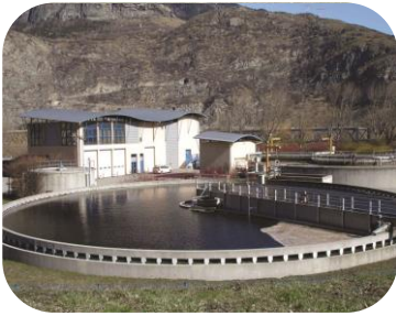
Station d'épuration de Saint-Jean-de-Maurienne
