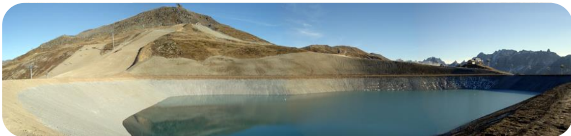
Retenue collinaire à Valloire, Savoie
