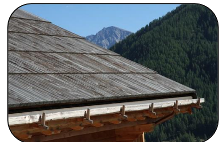
Toiture de chalet
