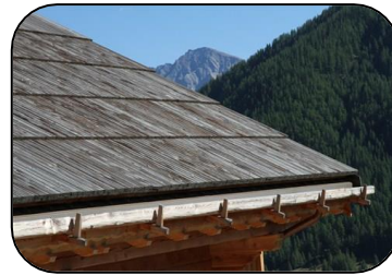
Toiture de chalet
