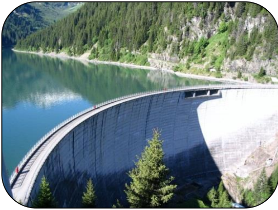
Barrage à haute chute
