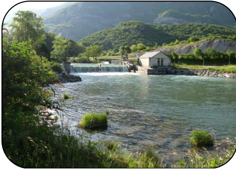
Barrage au fil de l'eau
